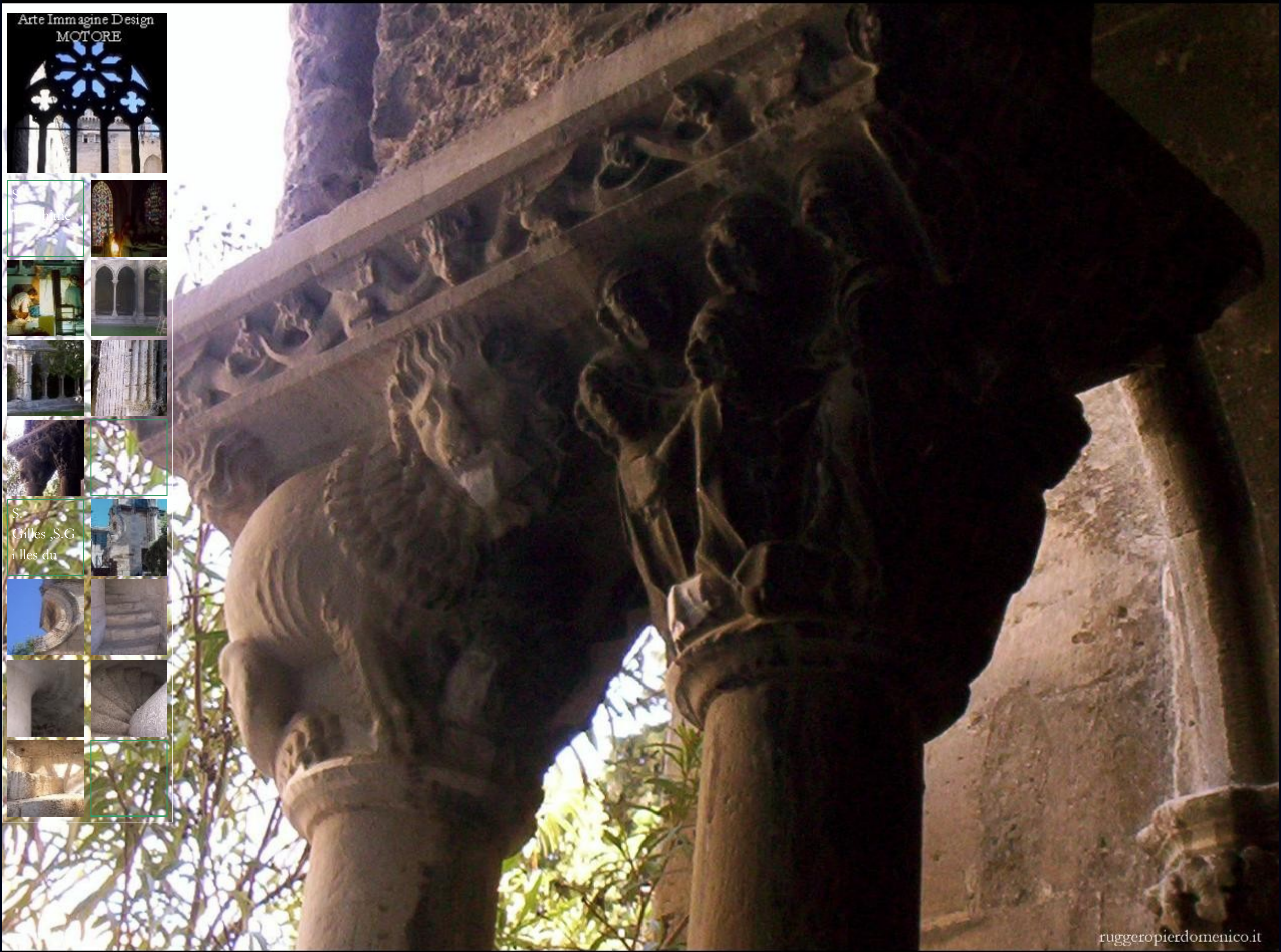
S. Trophime ( Arles ) ,cortile interno , particolare , analisi per il restauro dei capitelli .
